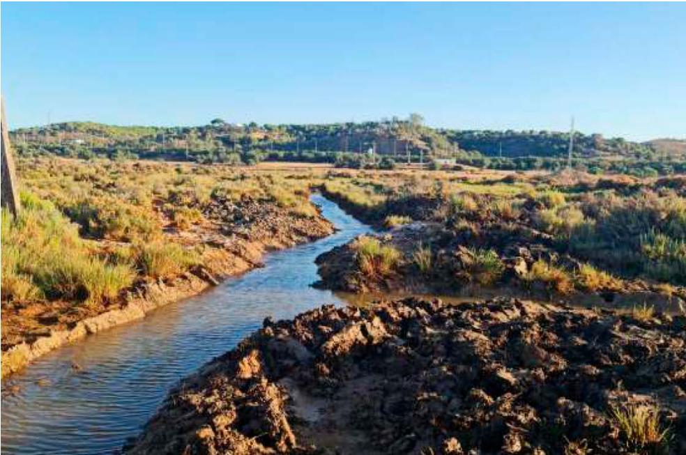
Fig. 29. Restauración hidrológica en parcela G5, Estero de La Nao (término municipal de Ayamonte; julio 2022). Reapertura de esteros colmatados, por la variedad e intensidad de los impactos que han propiciado una importante acumulación de sedimentos en la red de drenaje natural: pastoreo, molino mareal, trazado carretera N-447, hornos de cal, etc.
