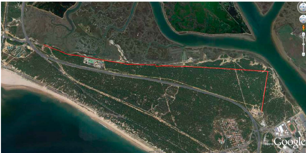
Sector Repetidor RTVE-La Peguera-P. Umbría
